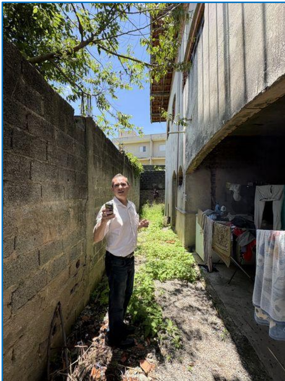
Foto 16 – Vista do recuo lateral esquerdo do imóvel objeto da demanda (lote 01).
